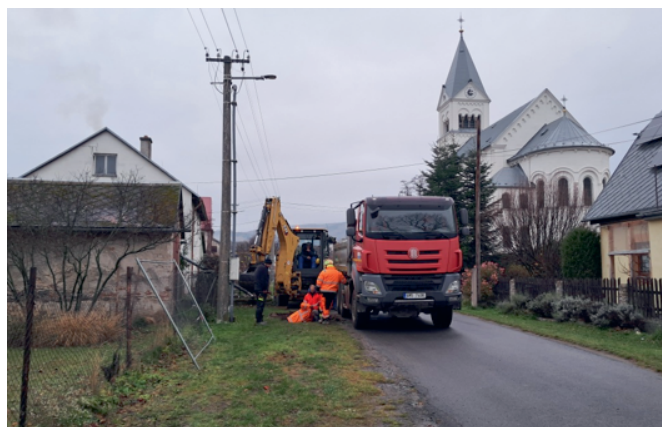
Akce bude provedena v letošním roce, a to v době, kdy teplota umožní manipulaci s vodovodním potrubím, foto: VaK
