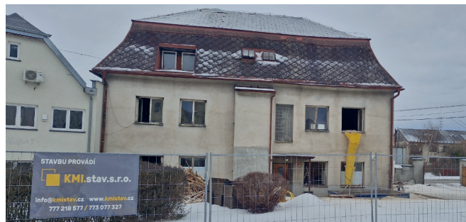
Kompletní rekonstrukce budovy dílen ZŠ Javorník na ul. Lidická zahájena, foto: MZ
