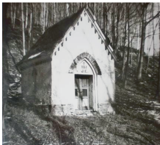
Foto před demolicí. Zdroj: Archeologie a historie v Rychlebských horách.
