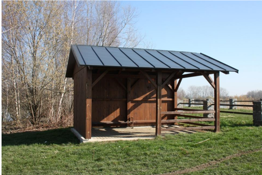
Obr.4 – vybudovaný přístřešek pro návštěvníky
