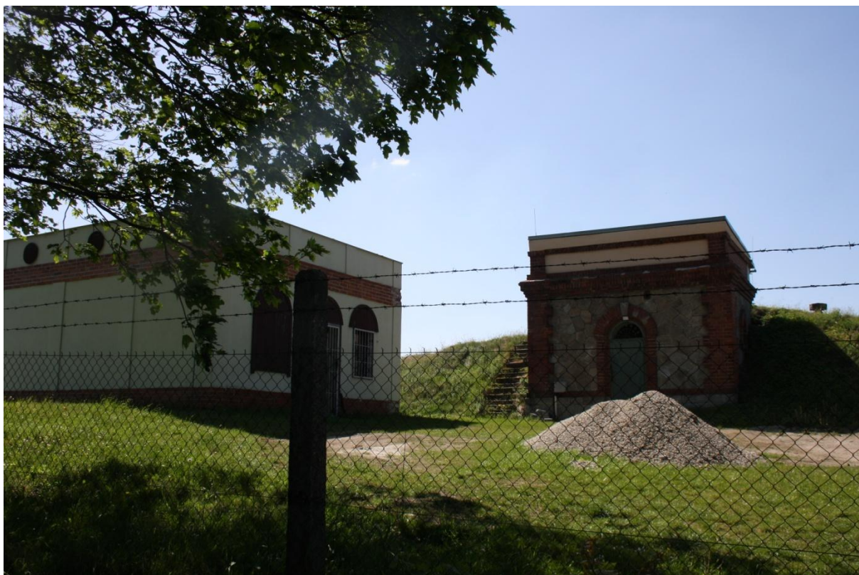
Obr.21–pohled na historickou budovu vodárny vybudovanou v roce 1901 (vpravo) a novou budovu vodárny vybudovanou ve 2.polovině 20.století (vlevo)
