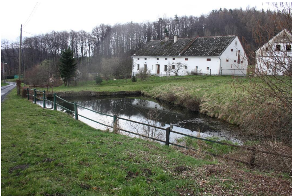
Obr.1 6–pohled na požární nádrž směrem od kostelíka
