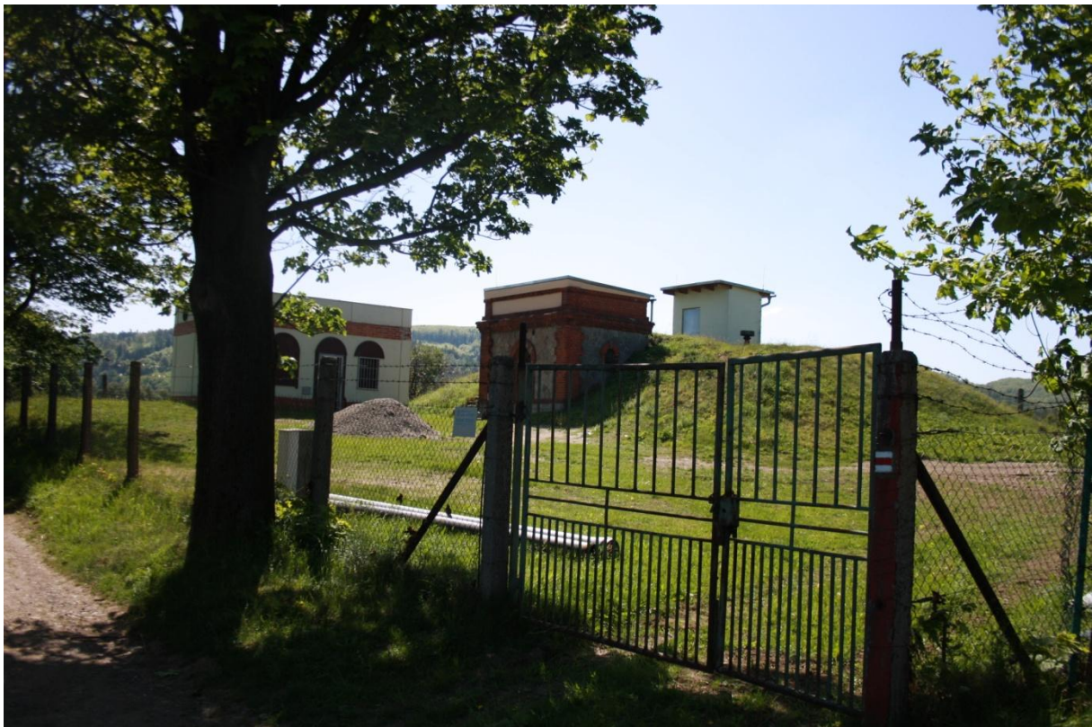
Obr.20–pohled na vstupní bránu od prostoru vodárny
