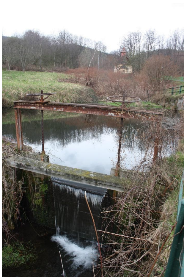
Obr.1 9–pohled na požární nádrž směrem ke kostelíku – stavidlo
