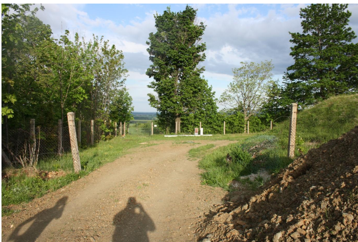
Obr.24–pohled na oddělané oplocení z důvodu výkopových prací.
