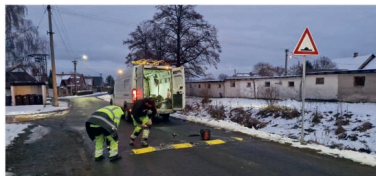
Havlíčkova ulice, montáž zpomalovacích prvků, foto: MZ
